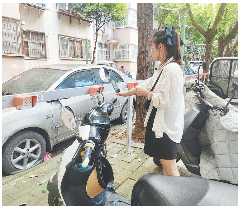
建井一处家属院增设智能充电桩,居民扫码为电动车充电。
