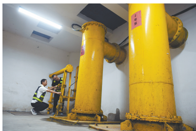
在光明路国铁立交桥雨水泵站,工作人员检修设备。
