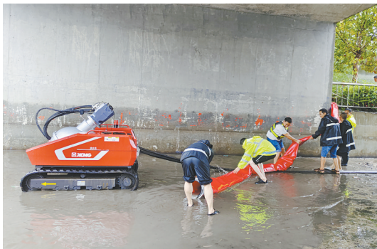
7月16日上午,平郊东路铁路涵洞内,工作人员调试大型设备——“龙吸水”排水抢险车。
