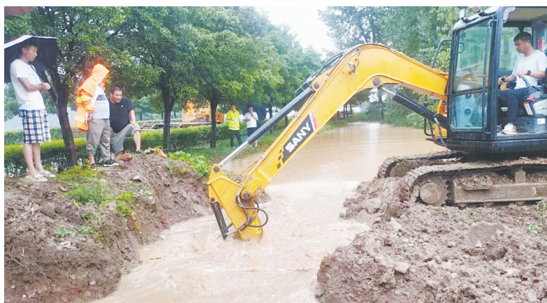
工作人员在S241洛驻线舞钢市尹集镇镇上村疏通边沟积水 尹亚东 提供
