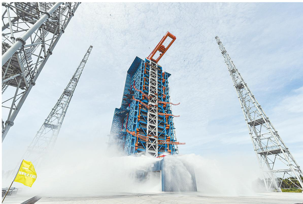
6月30日在海南商业航天发射场一号发射工位拍摄的喷水试验。
