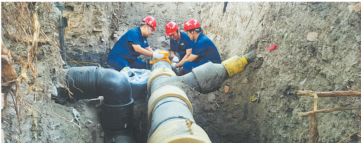
5月16日，平燃公司对神马大道与诚朴路交叉口附近的老旧管网进行改造
