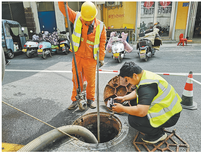
5月6日,市城市管理局市政环卫事务中心的工人在中兴路与湛河南路交叉口附近清疏雨污管网。
