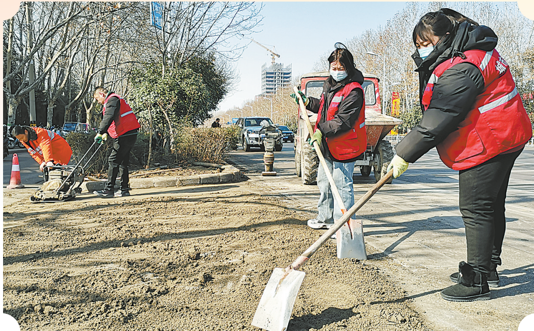
（右二）正在修补路面 翟利冰（右一）和石金花
