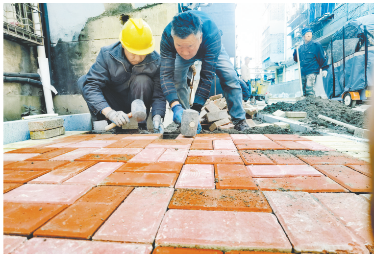
施工人员铺地砖
