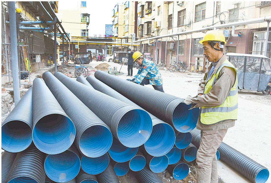
1月9日,在市区白银路中段金泰利小区,施工人员有序安放地下管道,升级小区排污管网。
