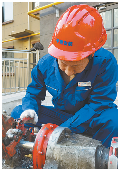
施工人员陈旭旭在对户内立厅管套丝
