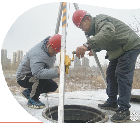
①工作人员在检查煤机厂阀井
