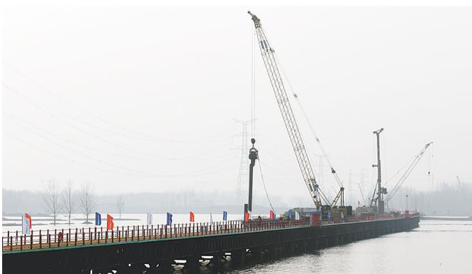
建设中的平漯周高铁鲁湛特大桥跨沙河钢栈桥
