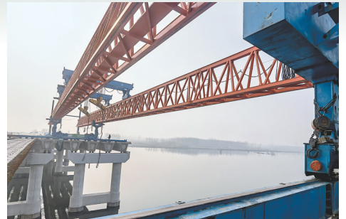
大桥合龙作业现场
