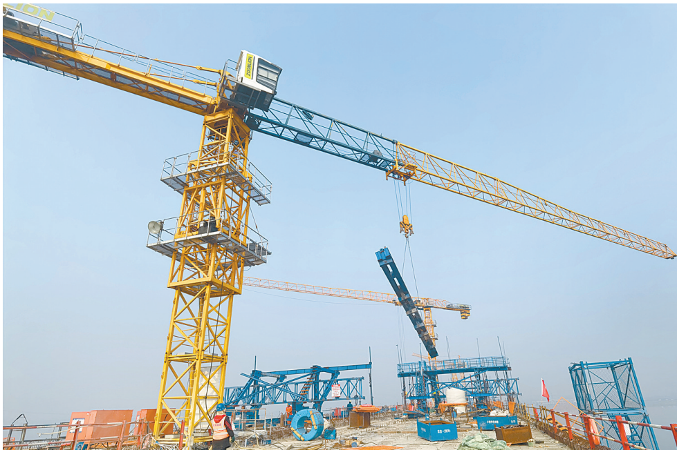
拆卸巨型作业平台钢架
