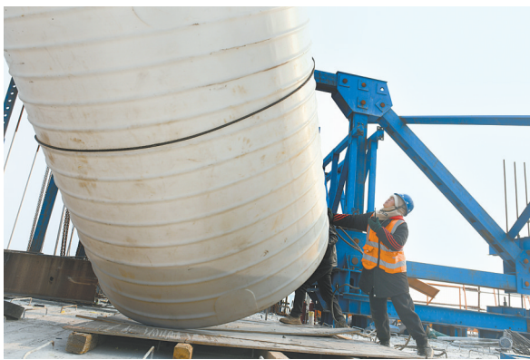
吊装超大配重水桶
