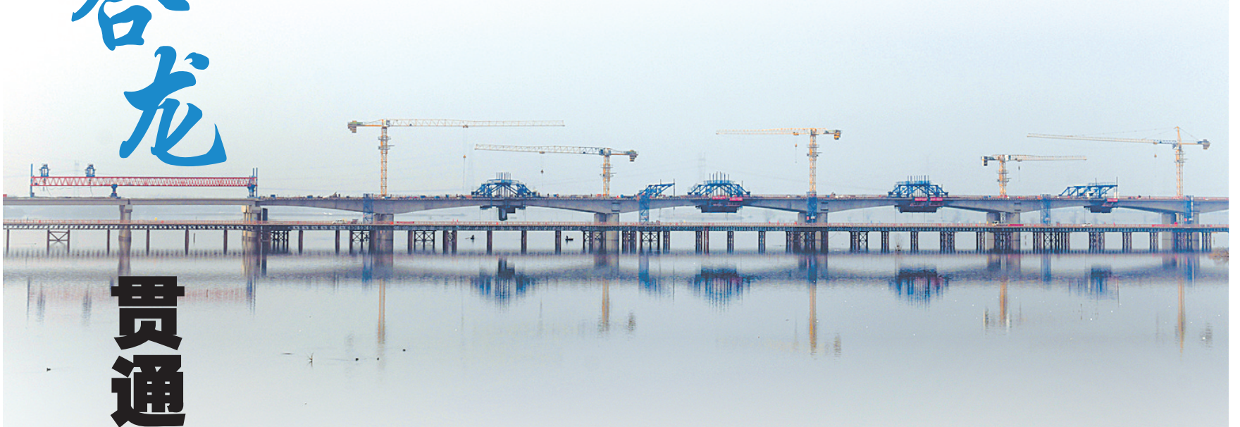
焦唐高速汝方段沙河特大桥施工现场
