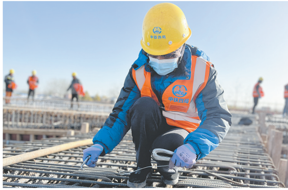
制作混凝土现浇钢筋网
