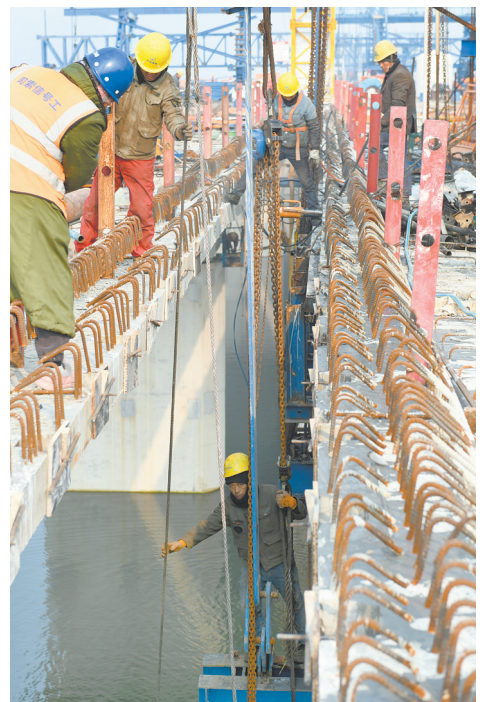
桥上桥下配合作业
