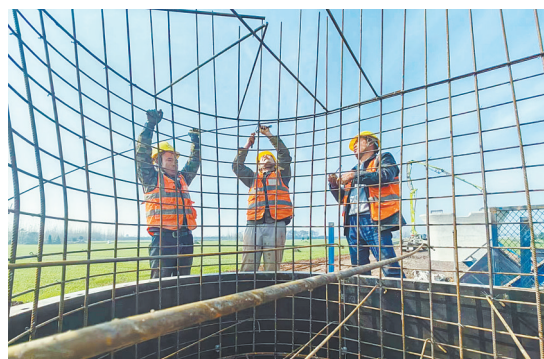
工人在三标段一工区编织墩身钢筋网
