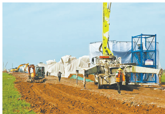
三标段一工区已建成8个墩柱
