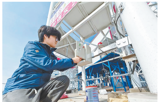
技术人员在湛河制梁场调试设备
