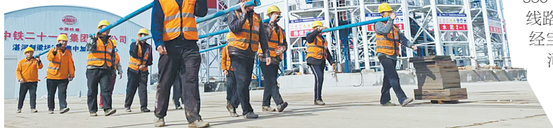
湛河制梁场忙碌的工人
