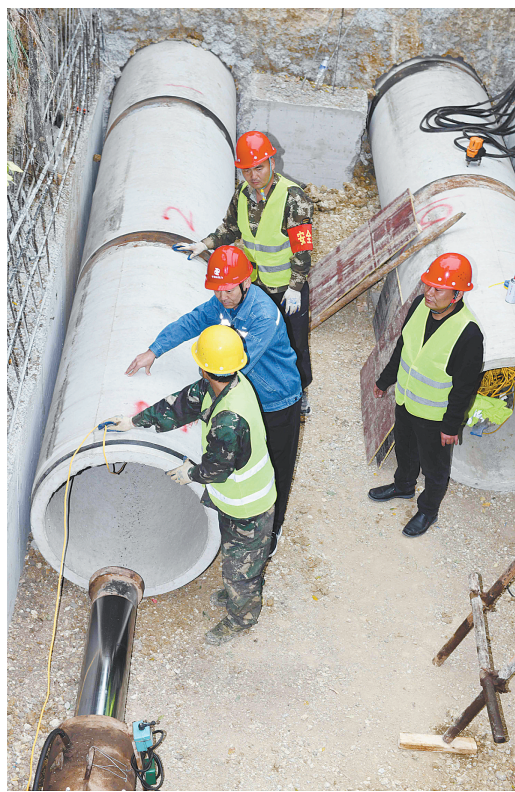
市城乡一体化示范区翠竹路北段,供热管道顶管施工现场,工人正在作业。
