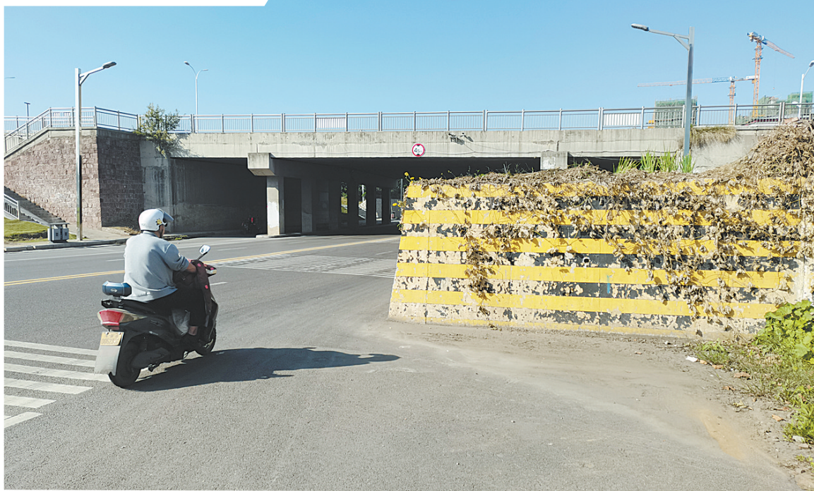
上图右侧带有黄色条纹的水泥墩,占据了非机动车道。
