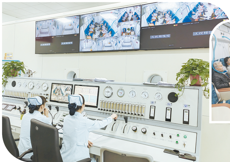
▲患者正在氧舱室里“吸氧” ▼值班护士在控制台前严密监测舱内各项指标
