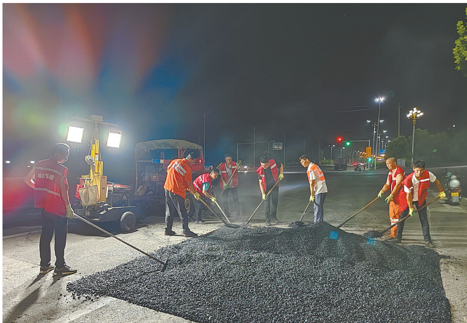
市政维修队工人正在修补路面
