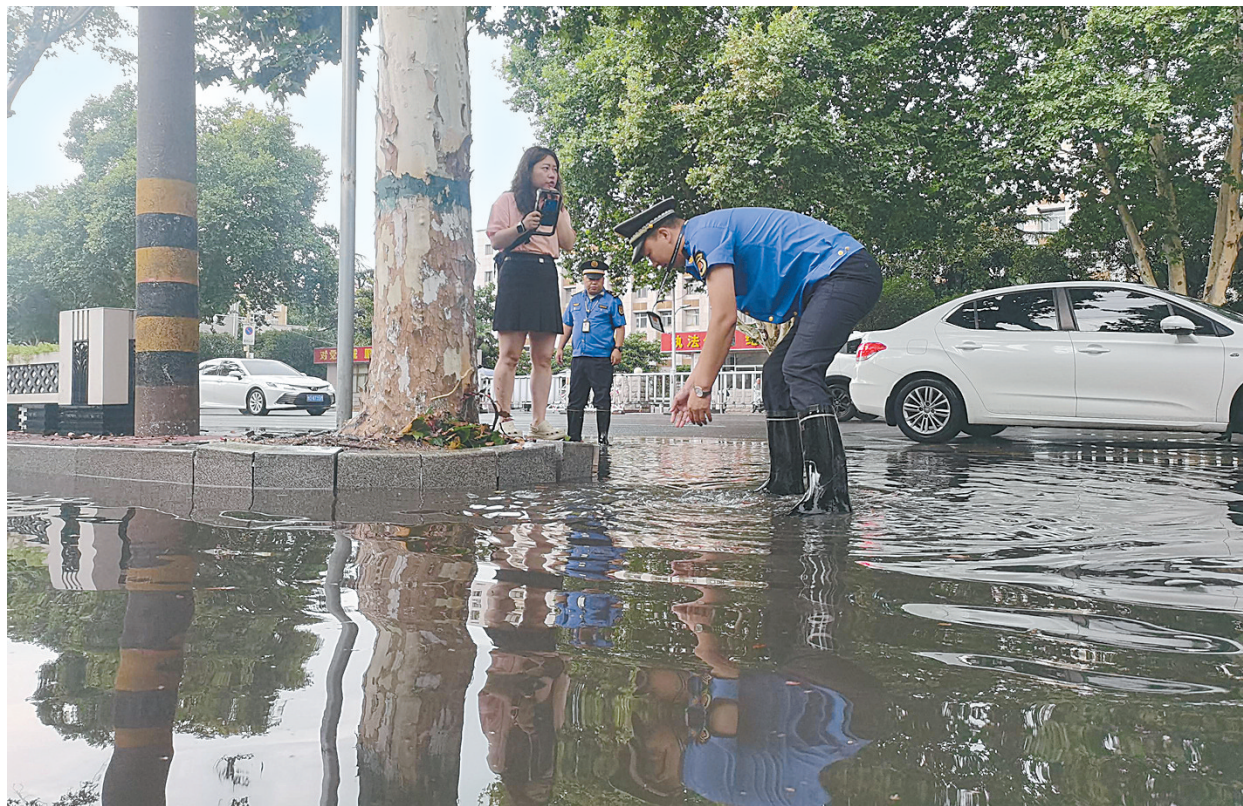
市区建设路积水两三厘米,城管人员正在清理堵塞下水道及雨水篦子。
