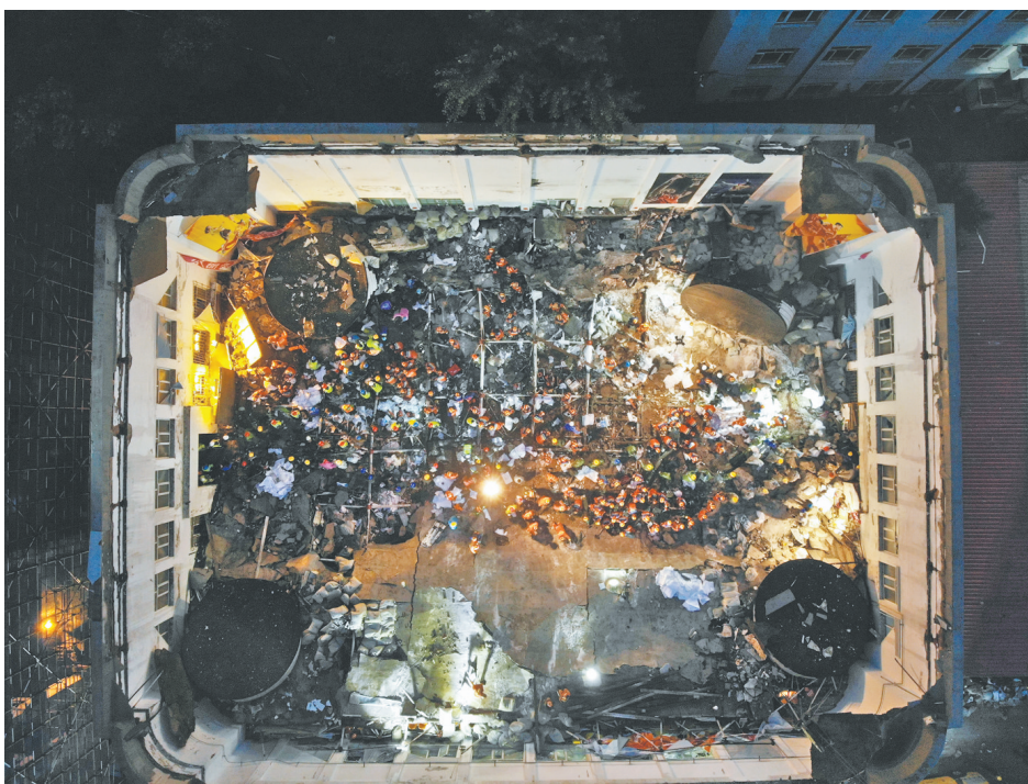
齐齐哈尔市第34中学体育馆屋顶坍塌事故搜救现场(无人机照片) 新华社记者 王松 摄
