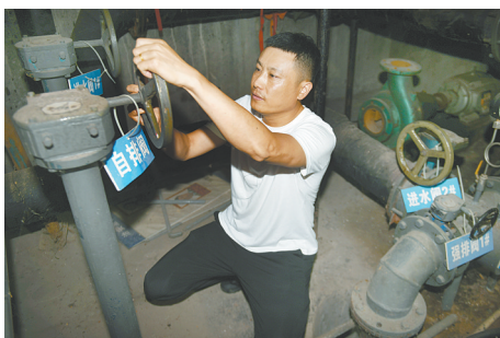
7月3日上午，湛河光明路橡胶坝地下泵房内，工作人员打开自排阀，调整湛河橡胶坝高度。 本报记者 禹舸 摄
