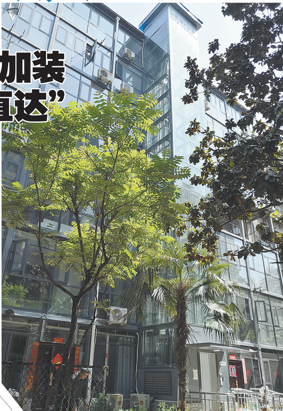
幸福小区3号楼居民加装了平层入户电梯
