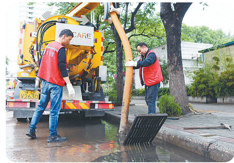
降雨过后，市区部分路段出现积水。5月4日，在市区鹰翔路西段，市市政环卫事务中心市政维修二队工作人员立即行动排除积水。本报记者 张鹏 摄
