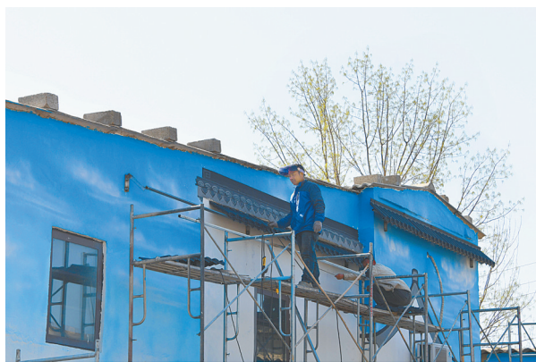
新华区安康(移民)村,施工人员正在美化民居外墙
