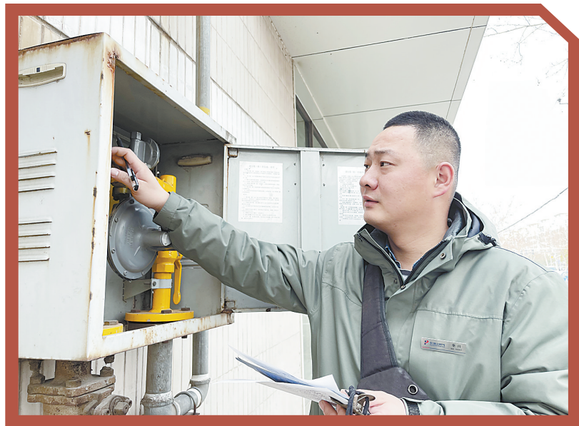
▲李闰在市区建设路西段检查燃气调压箱
