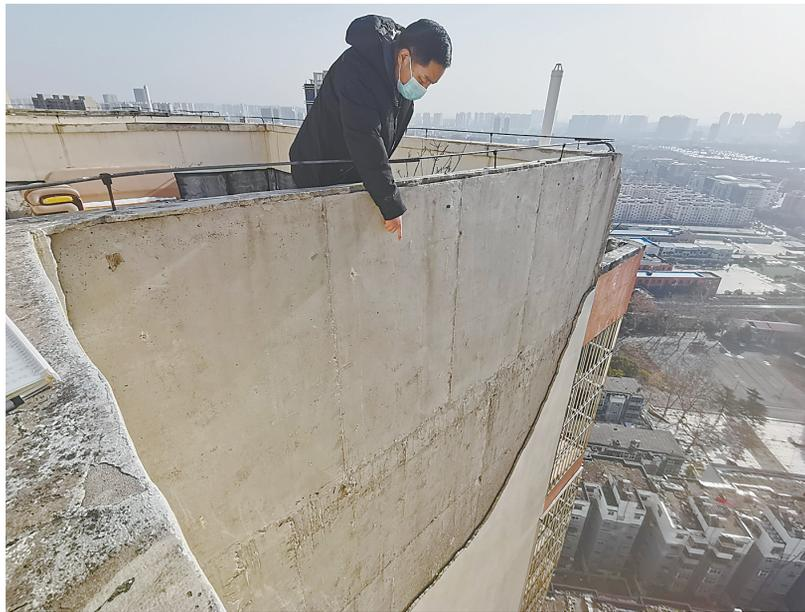
该楼高层外墙皮脱落后的墙面
