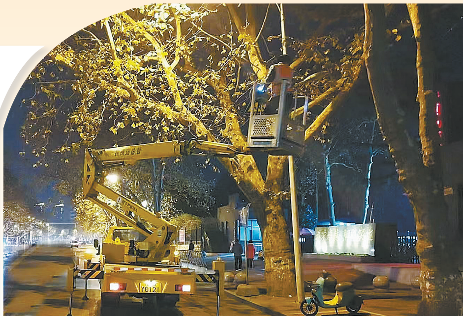
上月30日19时许,市路灯管理所工作人员在市区矿工路东段进行路灯维修。
