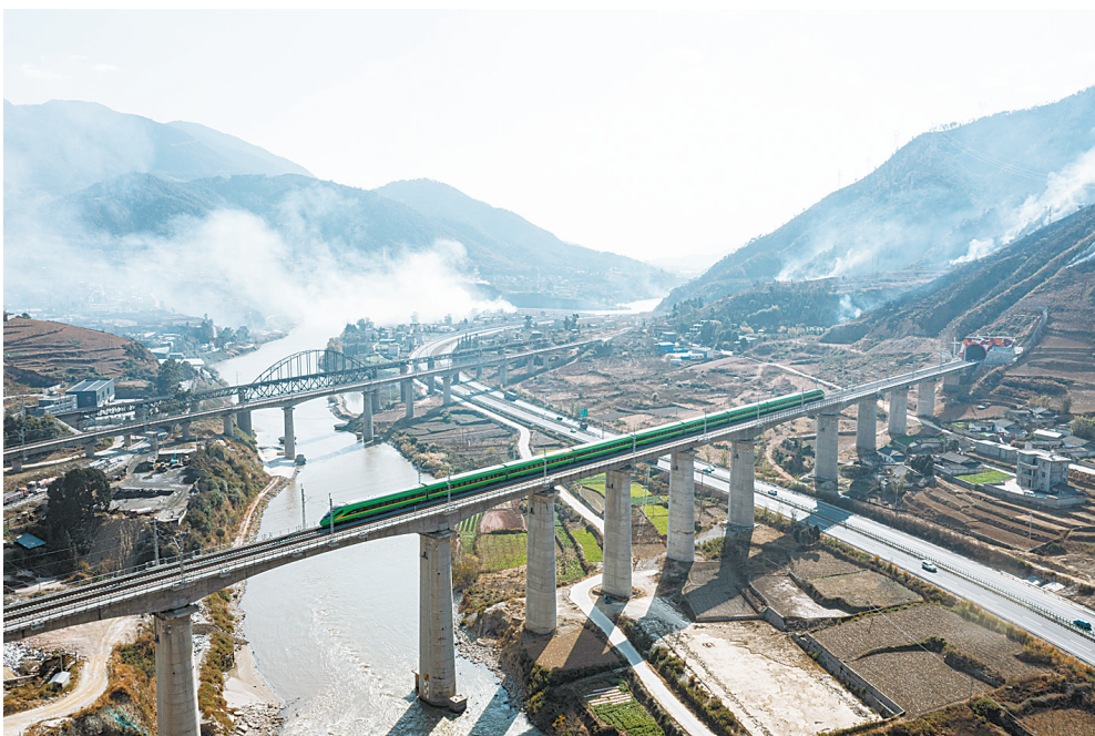
12月26日,C45次列车行驶在新成昆铁路上(无人机照片)。新华社记者 江宏景 摄
