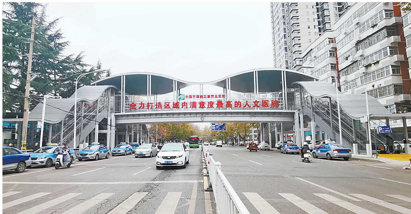
改造后的总医院北侧过街天桥
