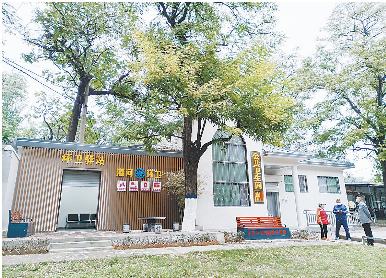
在市区西苑小区北门以东,改造完成的公厕焕然一新。
