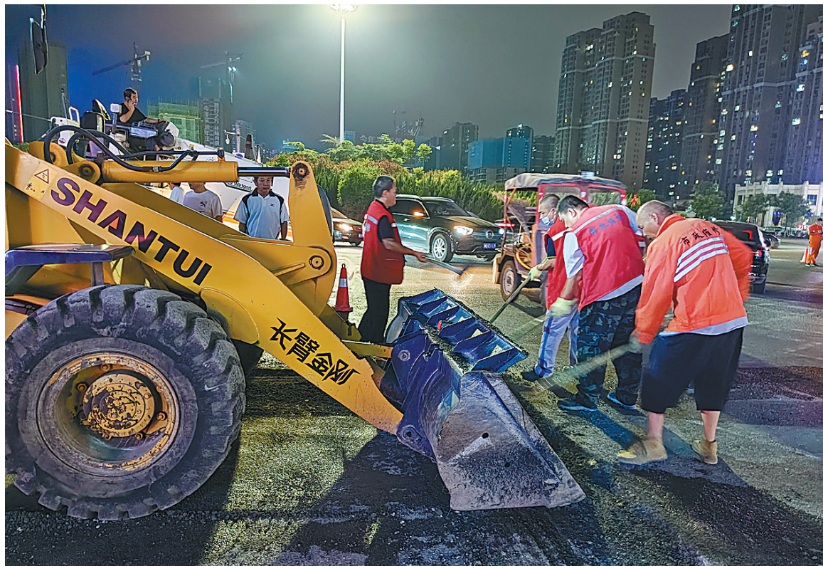
市市政维修队工作人员正在修补破损的路面
