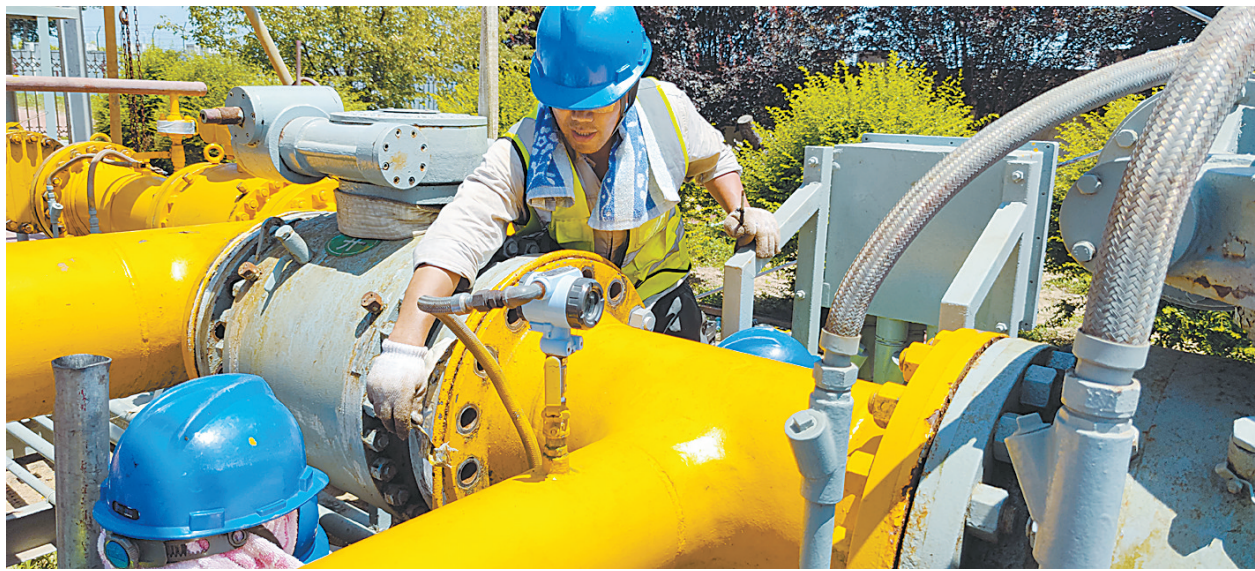
工作人员正在施工,进行设备改造
