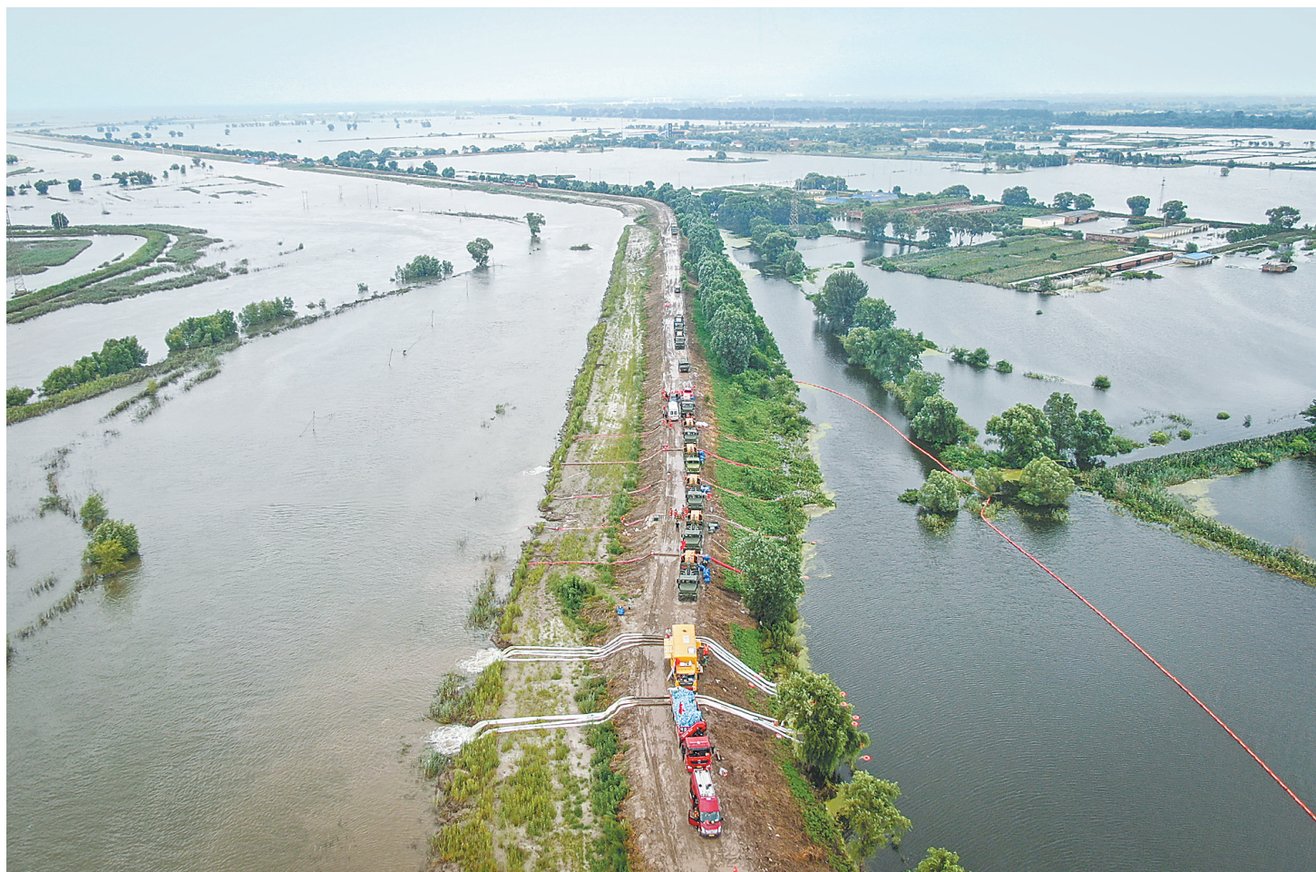
辽宁绕阳河溃口结束封堵 灾后排涝启动
