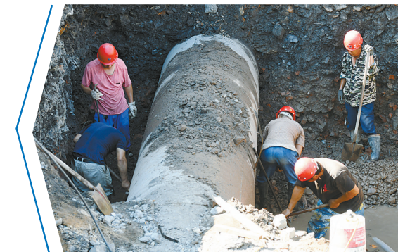
清理管道下的泥土
