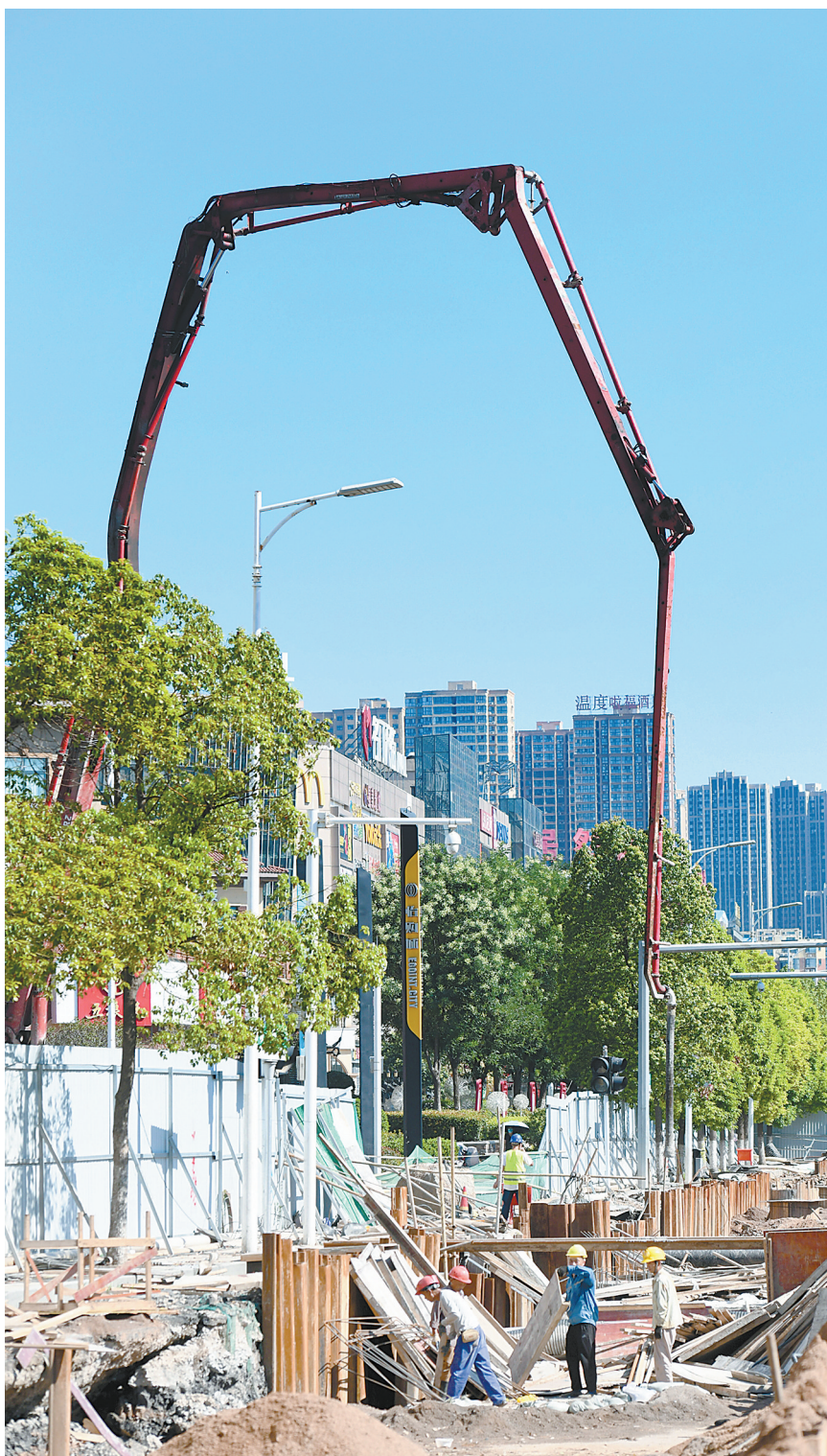
市区凌云路与园林路交叉口,混凝土搅拌罐车通过巨型导臂向雨水管渠注入混凝土。
