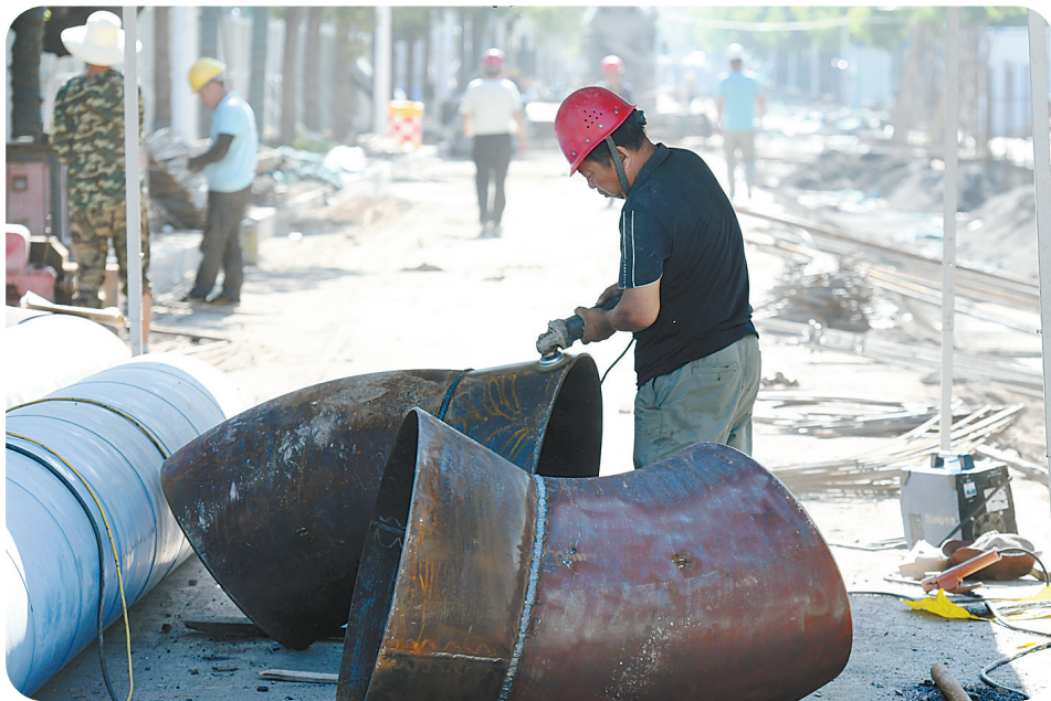
打磨管道弯头
