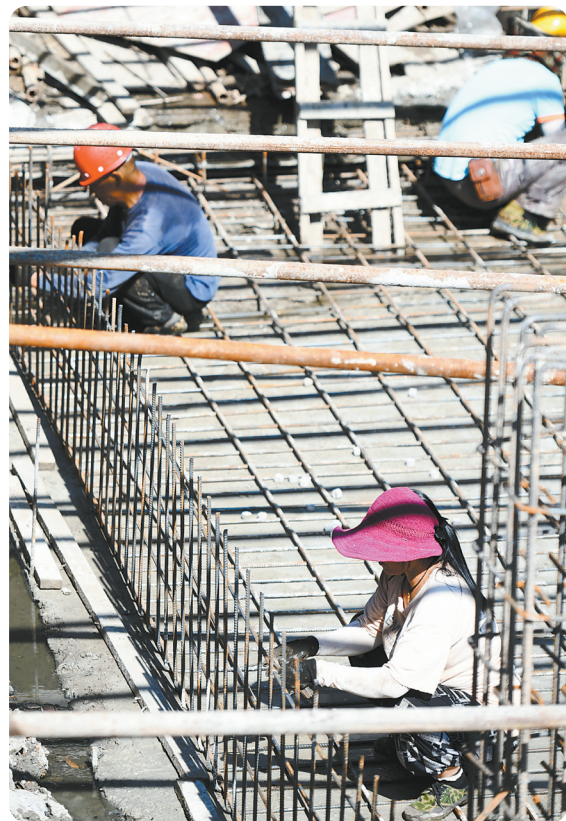
编制钢筋框架
