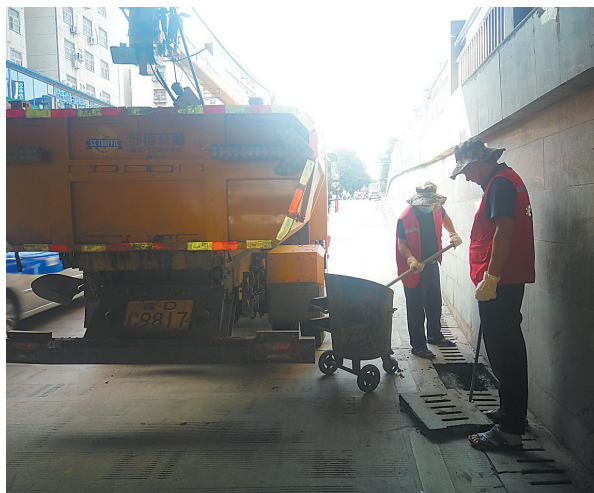
市政维修二队清掏班职工李铁林、杨传信在亚兴路立交桥下清掏下水道
