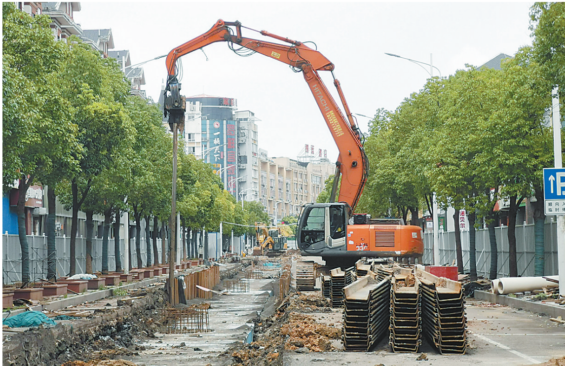
在园林路工地上,工人用打桩机拆钢板桩
