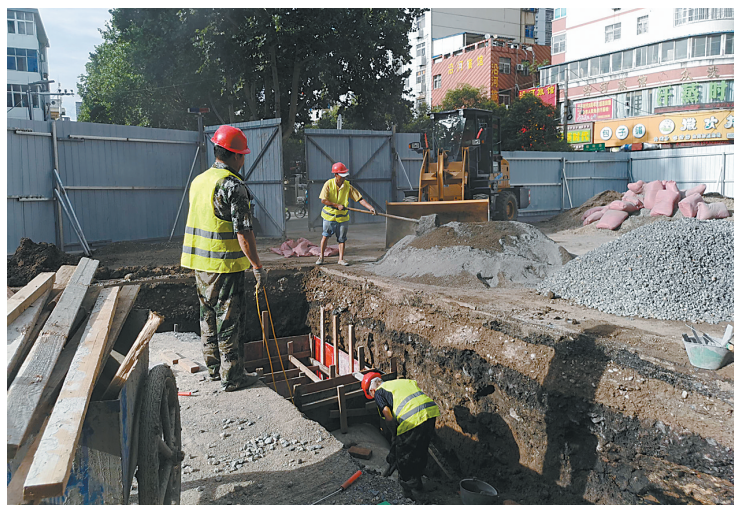
联盟路与迎宾路交叉口工地上,工人正在修建观察井
