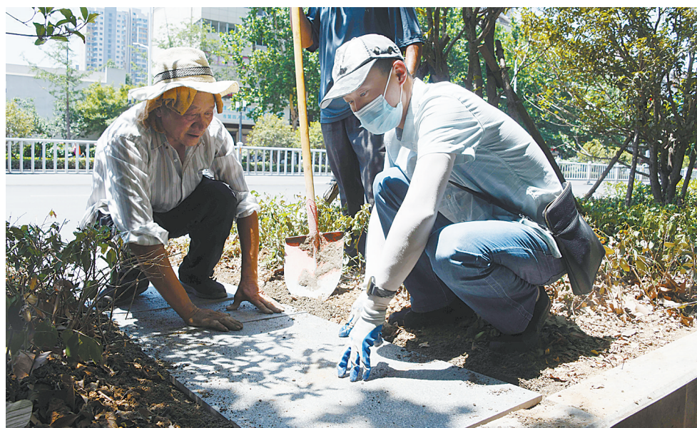
建设路沿线 铺设石板小径
