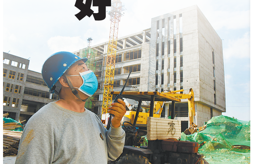
新华区高新技术产业园区,工人正加紧施工
