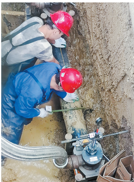
平顶山燃气公司工作人员在宝丰县父城路工程建设现场进行施工。
