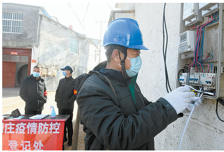
1月15日上午,在城乡一体化示范区滨湖街道闫庄村,国家电网华辰供电公司的工作人员为该村疫情防控卡点布设临时线路。
