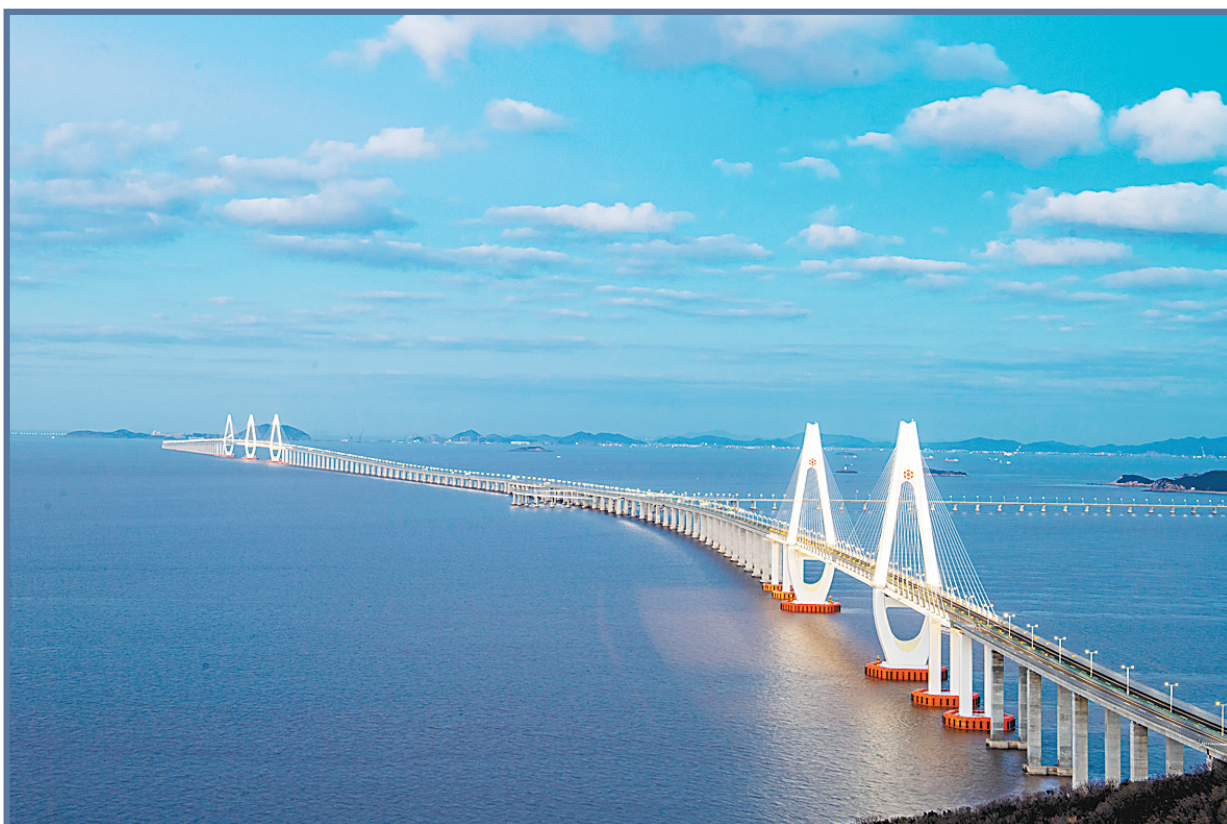
浙江:舟岱大桥正式通车
