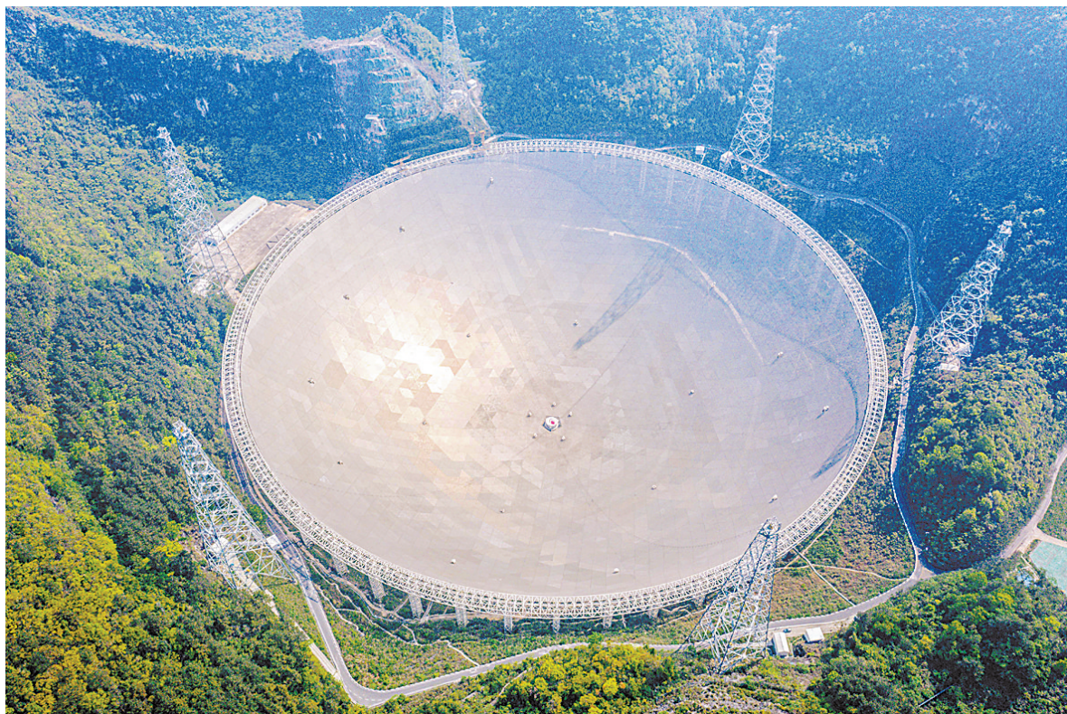
3月31日拍摄的“中国天眼”一景(维护保养期间拍摄,无人机照片)。新华社记者 欧东衢 摄
