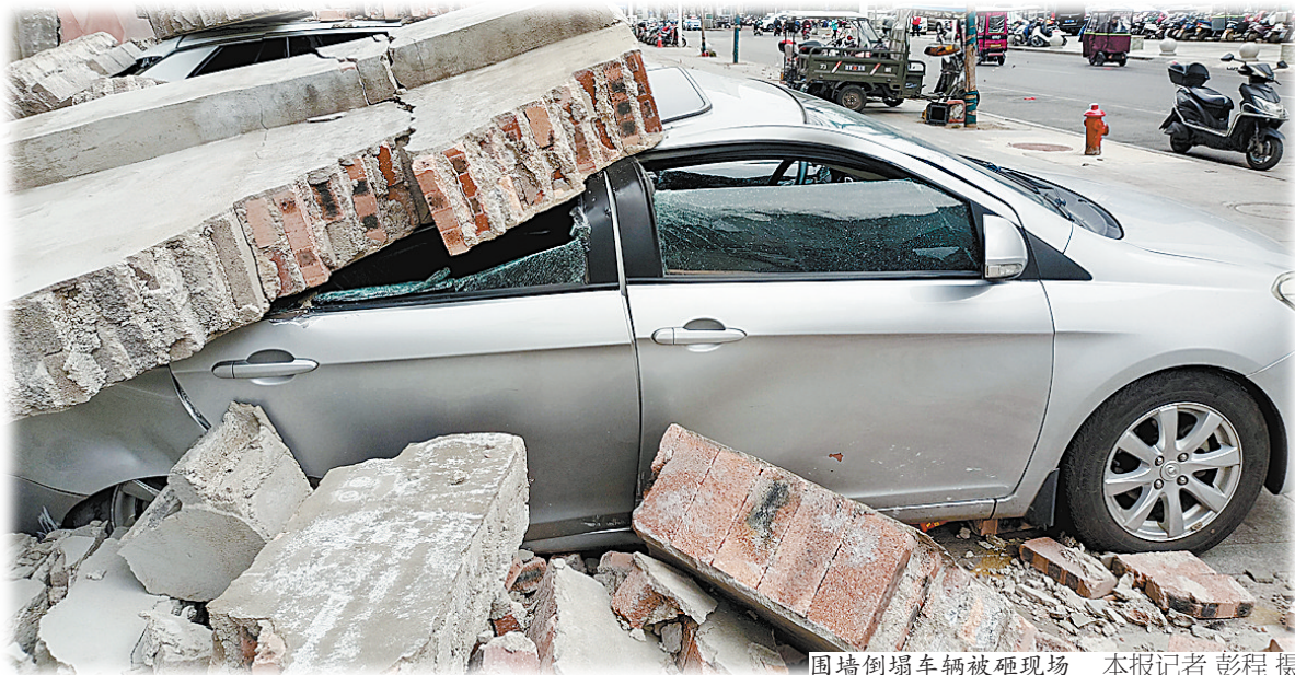
围墙倒塌车辆被砸现场 本报记者 彭程 摄
