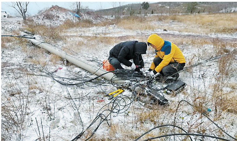
11月7日，在汝州市纸坊镇，平顶山移动工作人员全力抢修受损光缆
