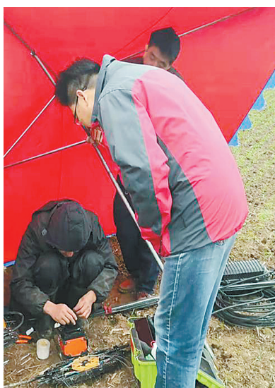
叶县叶邑镇，平顶山电信工作人员抢修光缆故障
