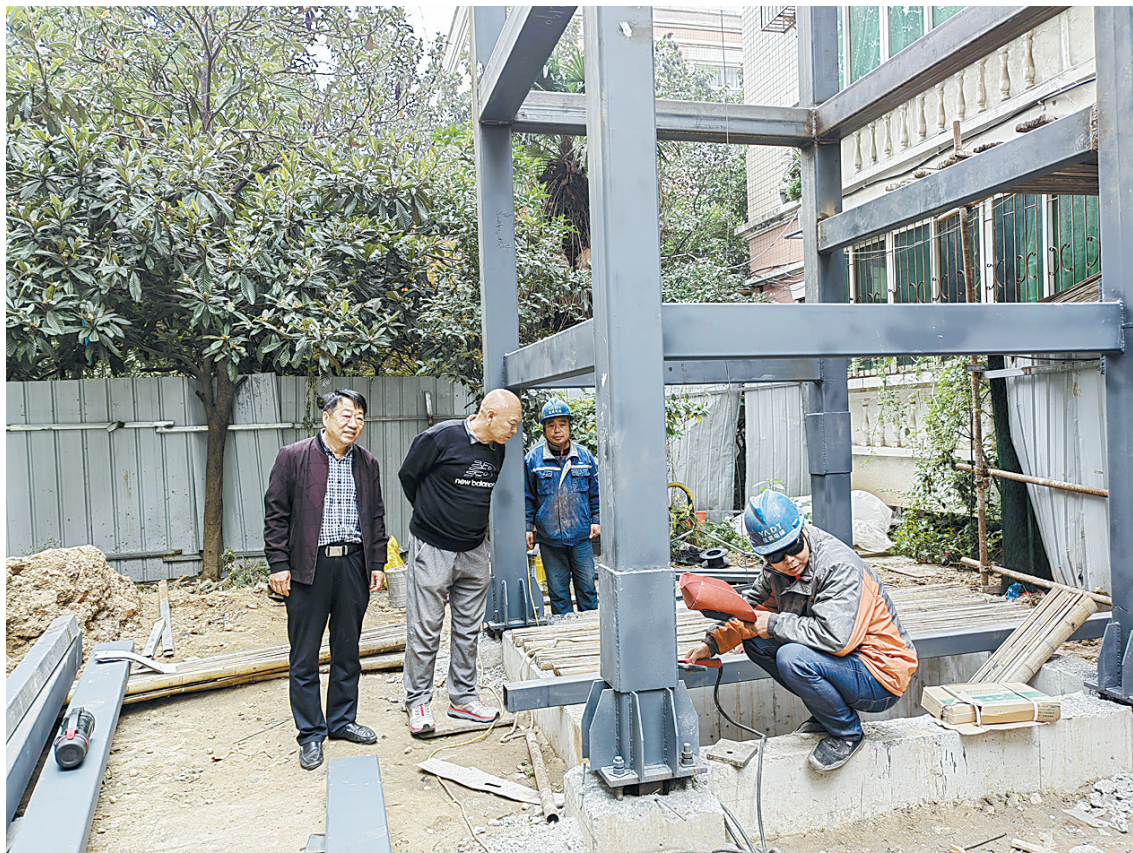
60号楼北面正在加装电梯,张志玲(左一)和侯国照(左二)了解工程进度
