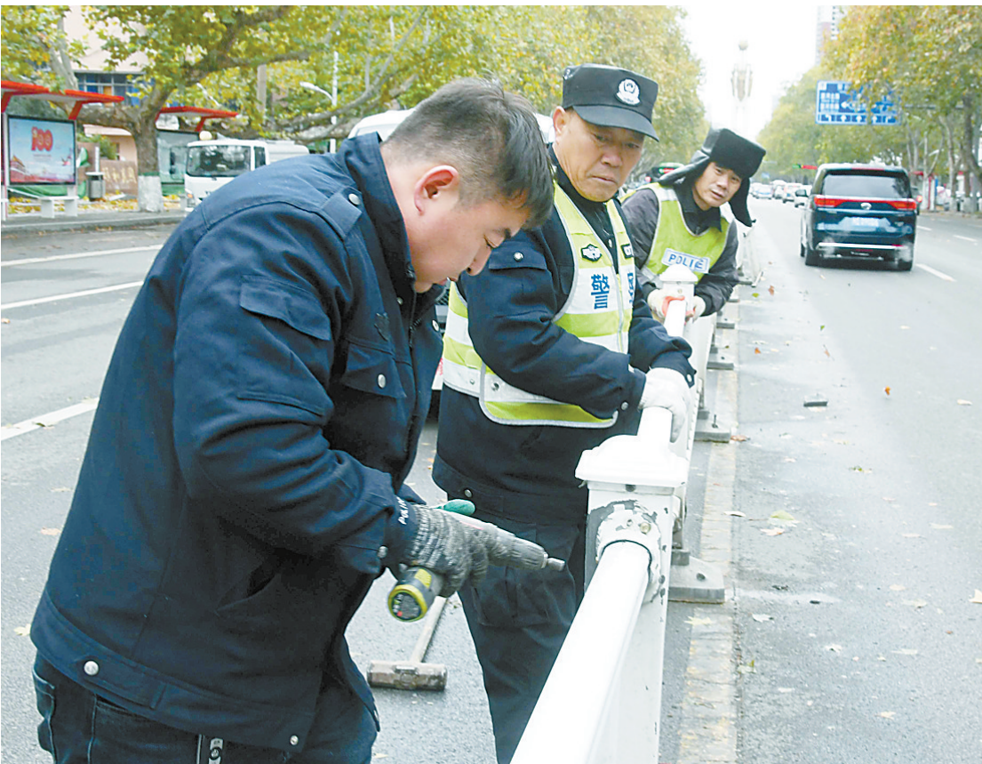
市区建设路东段,交通管护人员在修复隔离护栏
