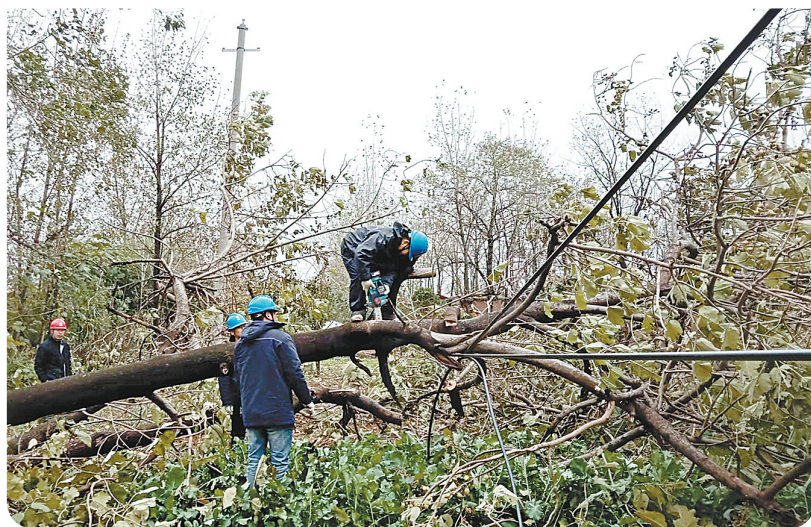
11月7日上午,舞钢市供电公司工作人员正在抢修中矿线前苗支线被大树压倒的电线杆。
