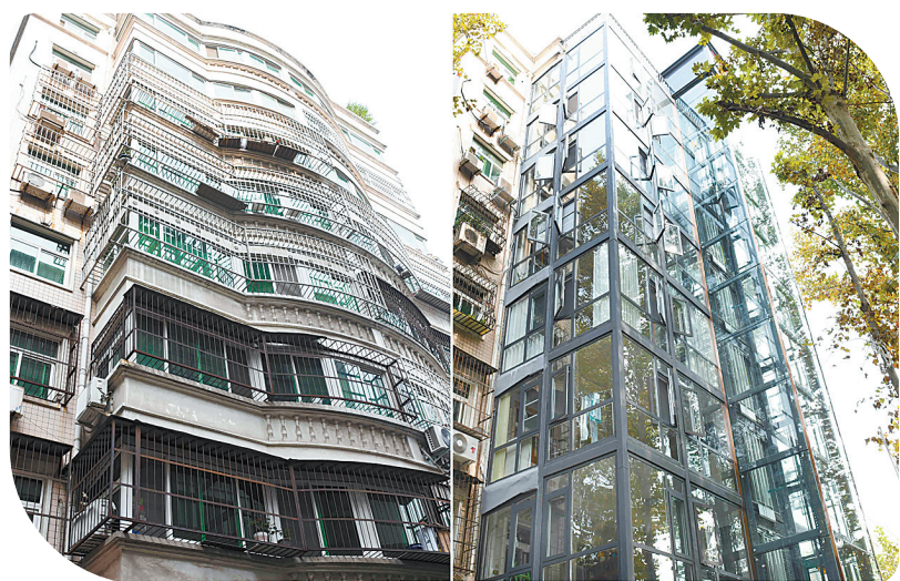
平高集团家属院60号楼加装电梯前后的变化
