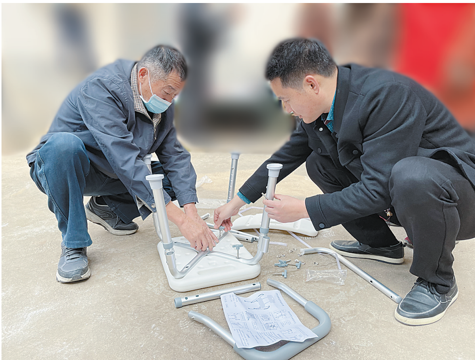
市残联工作人员在鲁山县张良镇姚吴程村残疾人阎振兰家中安装洗澡椅
