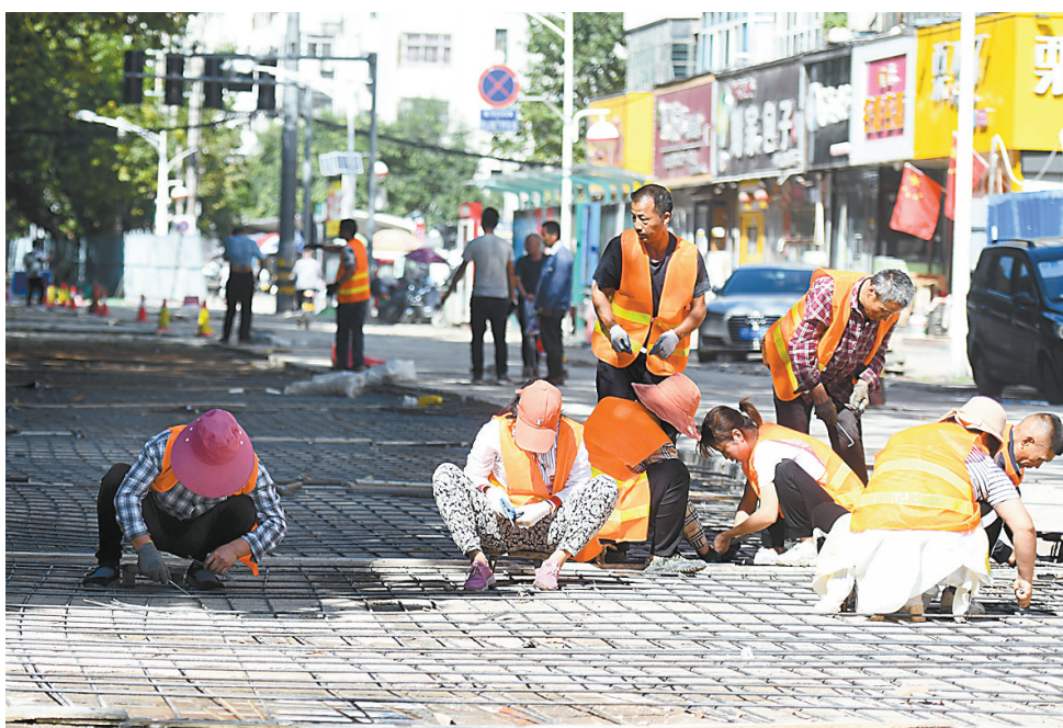
加紧修复道路
